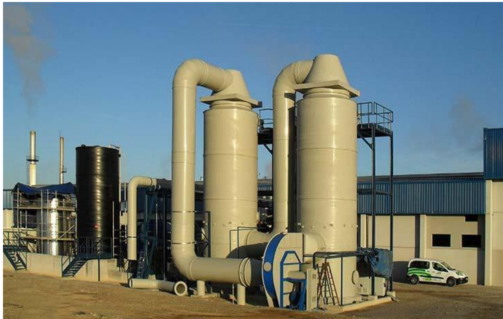
Figura 18. Sistema Stripping – Scrubber propuesto («ECOTEC», s.f)
