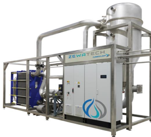
Figura 16. Evaporador de lixiviados a vacío con empleo de calor residual («Evaporadores para la Depuración de Aguas Residuales», s.f.)
