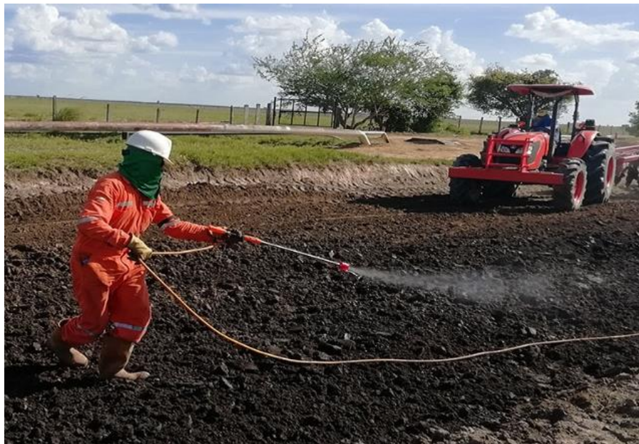
Figura 8. Ejemplo real de aplicación de técnica landfarming
