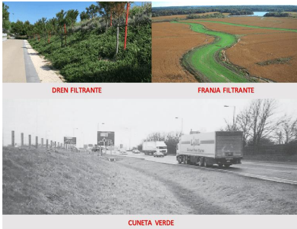
Figura 5. Sistemas de captación y transporte.
